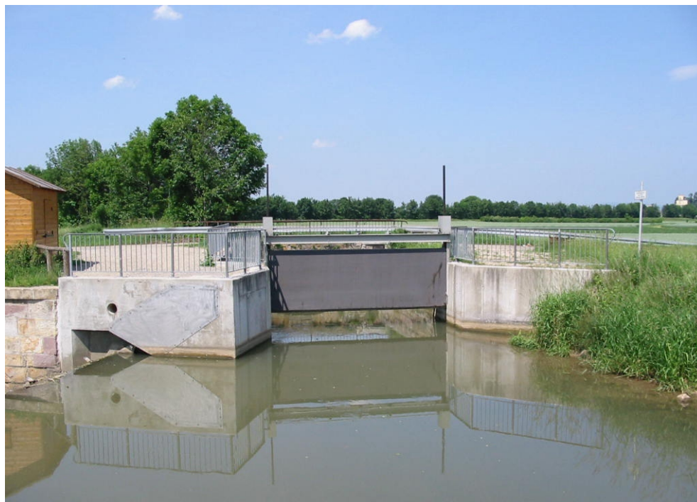
Ansicht der Wehranlage vom Oberwasser
