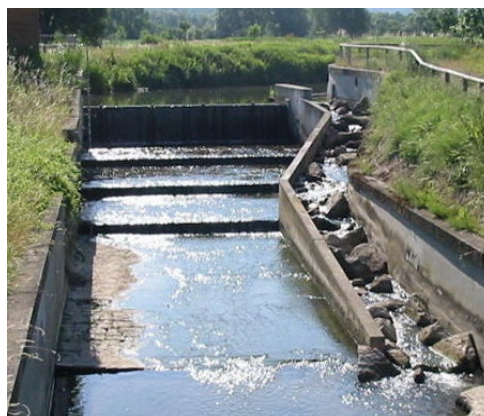
Fischbauchklappe und Fischaufstieg von UW
