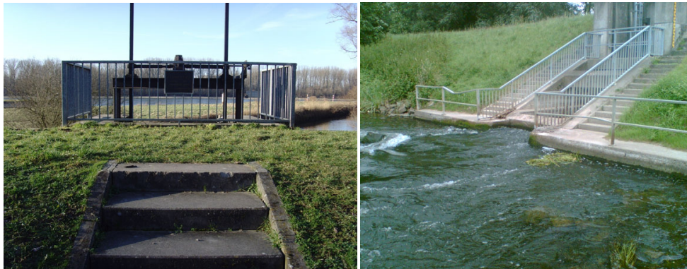
Vorhandenes Bauwerk bei der Albmündung
