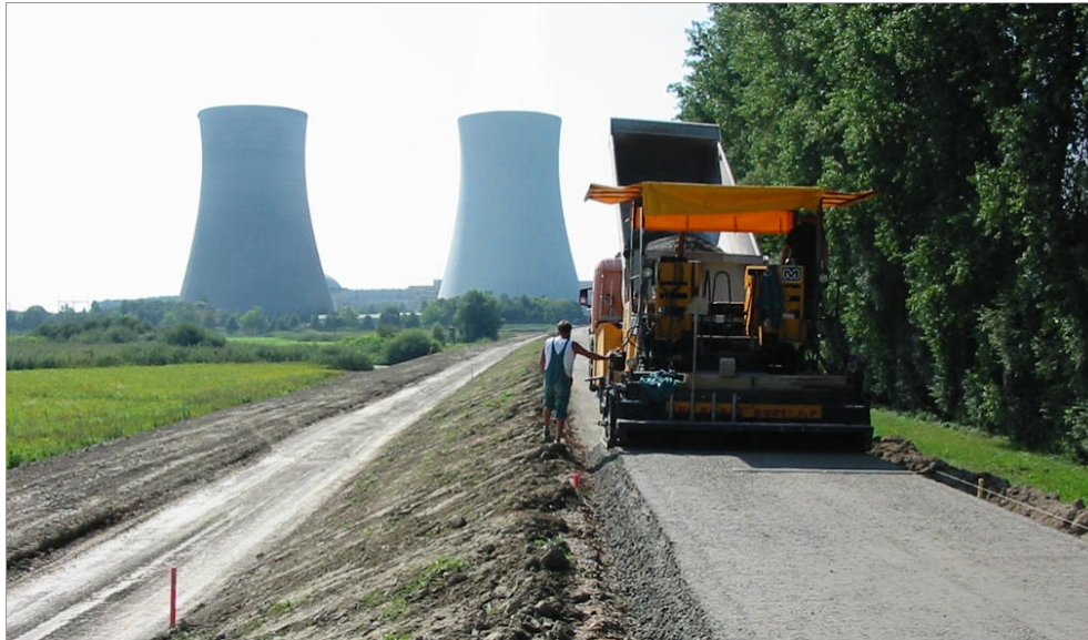
Einbau der HGTD auf dem Dammkronenweg
