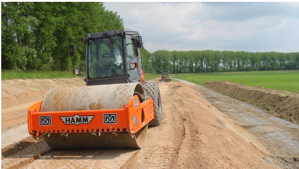
Verdichtung der polderseitigen Dammverstärkung mit Kiessand
