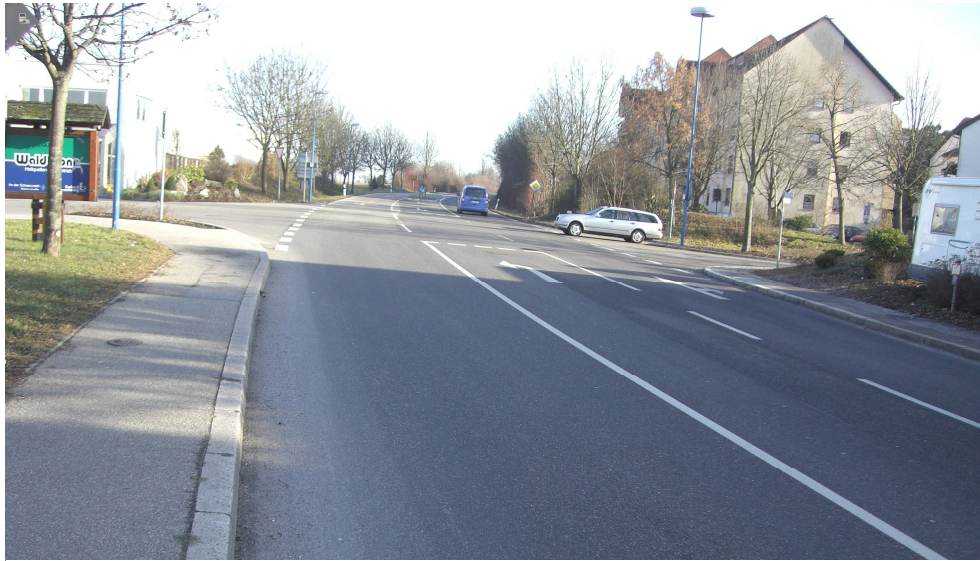
Bild: Bestehende Kreuzung, Blickrichtung Ortsausgang (Osten)
