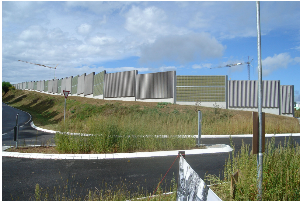
Ansicht der fertig gestellten, noch nicht begrünt Lärmschutzwand 10/2009
