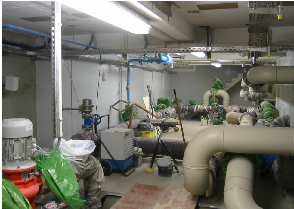
Rohrleitungs- und Pumpenkeller während der Umbauarbeiten
