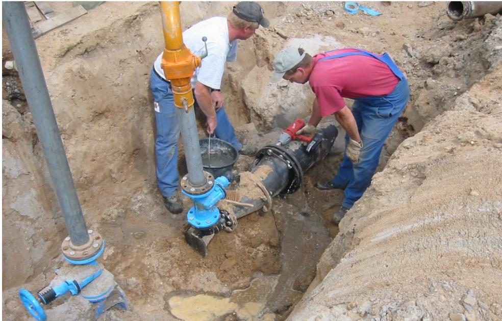
Abbau der Einspeisevorrichtung zur Desinfektion der Rohrleitung
