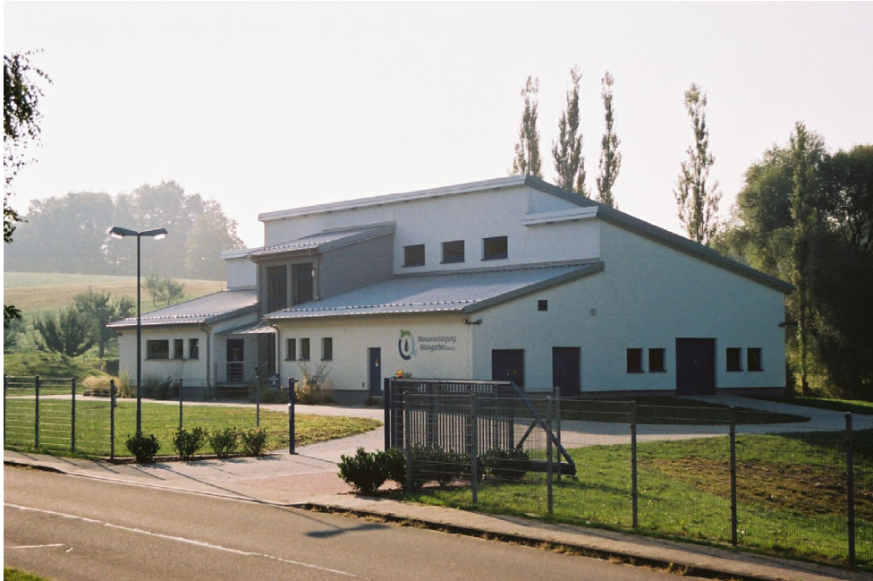
Ansicht der Trinkwasseraufbereitungsanlage
