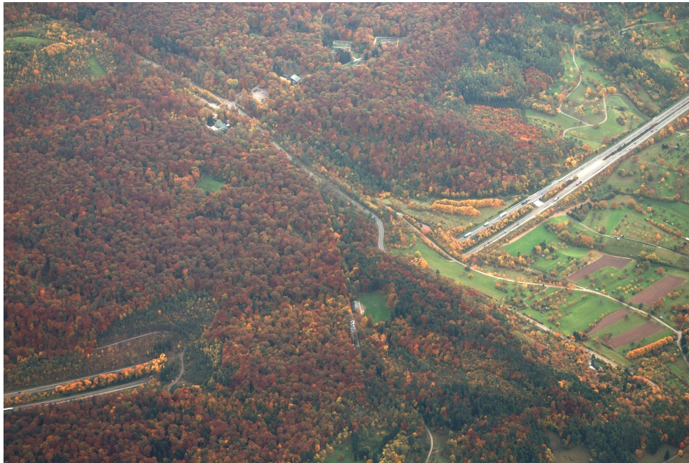
Luftbild des Schönbuchtunnels
