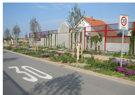
Kombinierte Lärmschutzwand Acrylglas/Beton
