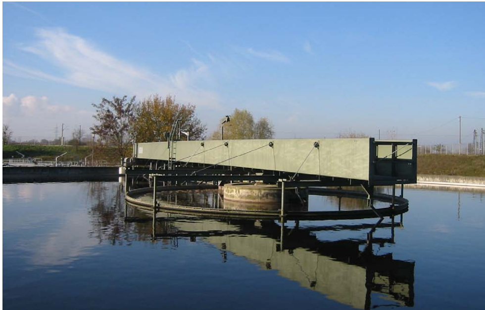
Nachklärbecken, Räumereinrichtung
