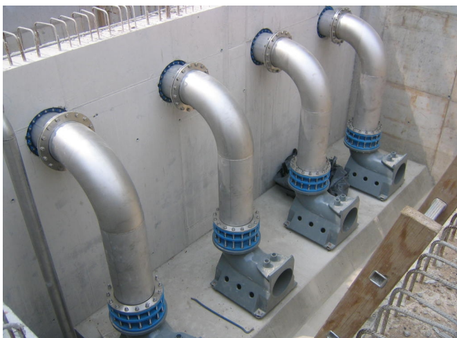
Einbau der 4 Tauchmotorpumpen
