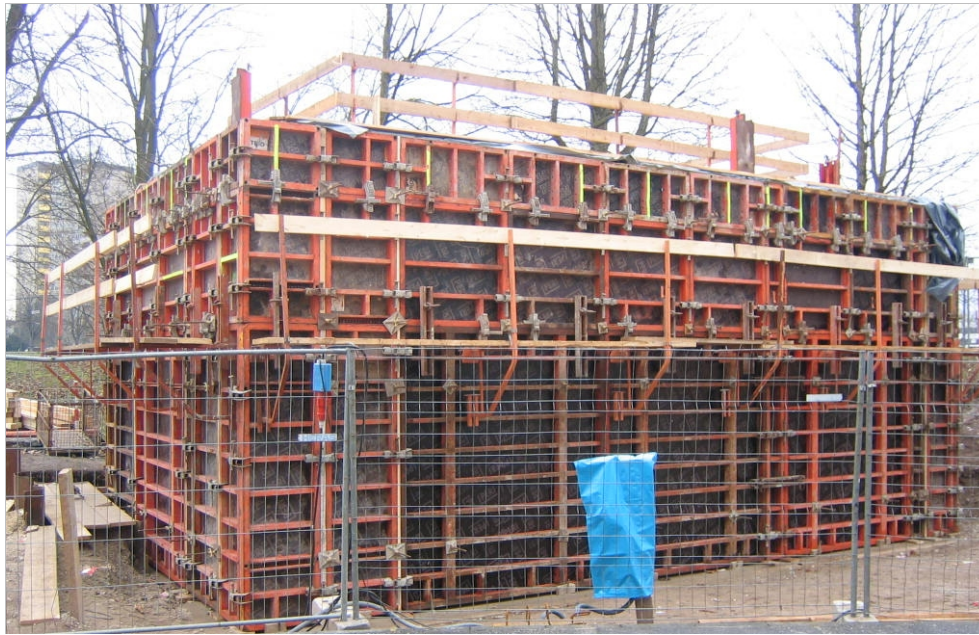
Schalung des Senkkastens
