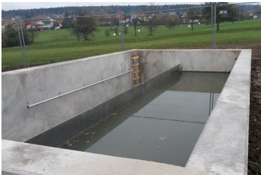
Neues Trennbauwerk mit Verlängerung der Schwellenlänge, RÜB Schwann
